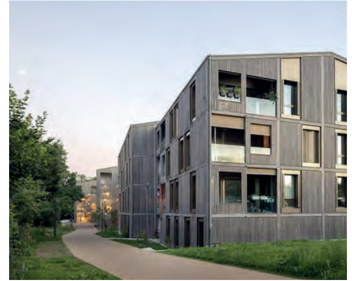
Het gebouw ligt aan het vestingpark en langs de belevingsroute.
