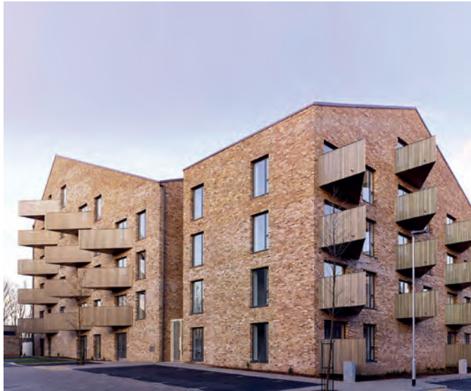
Kenmerkend is de sculpturale vormgeving van het gebouw met het samengestelde dakontwerp.
