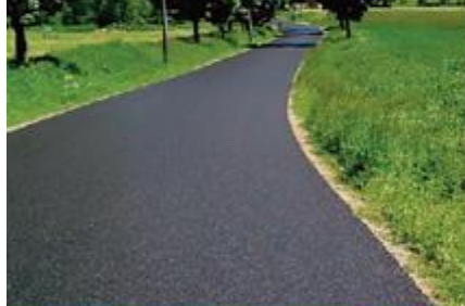
KLEIN ONDERHOUD ASFALT
